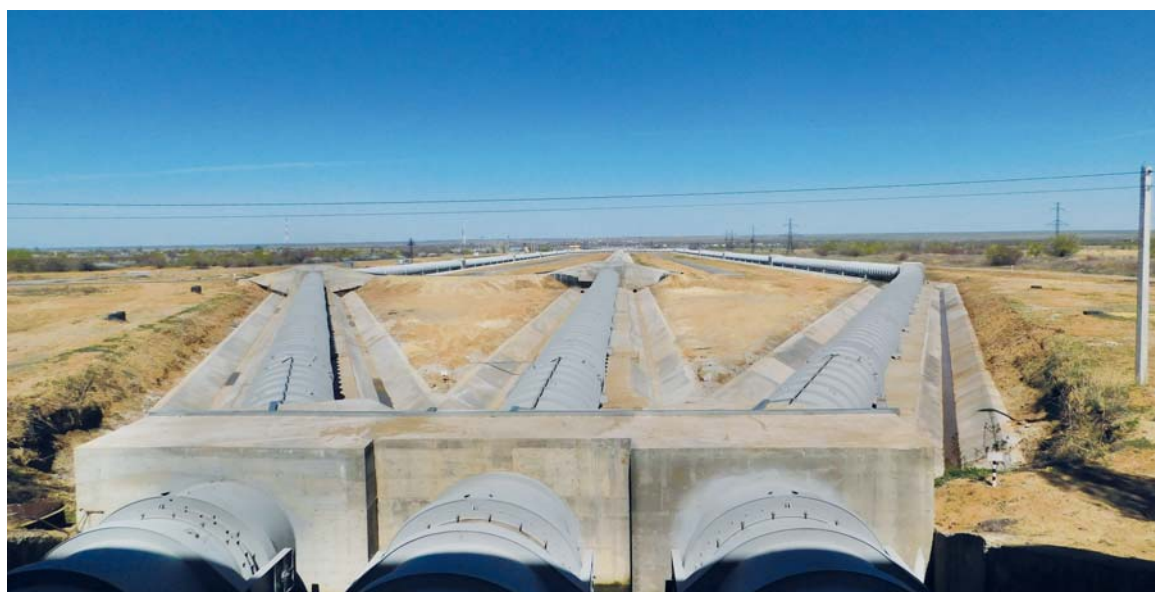
Реконструкция трубопровода Т-34
