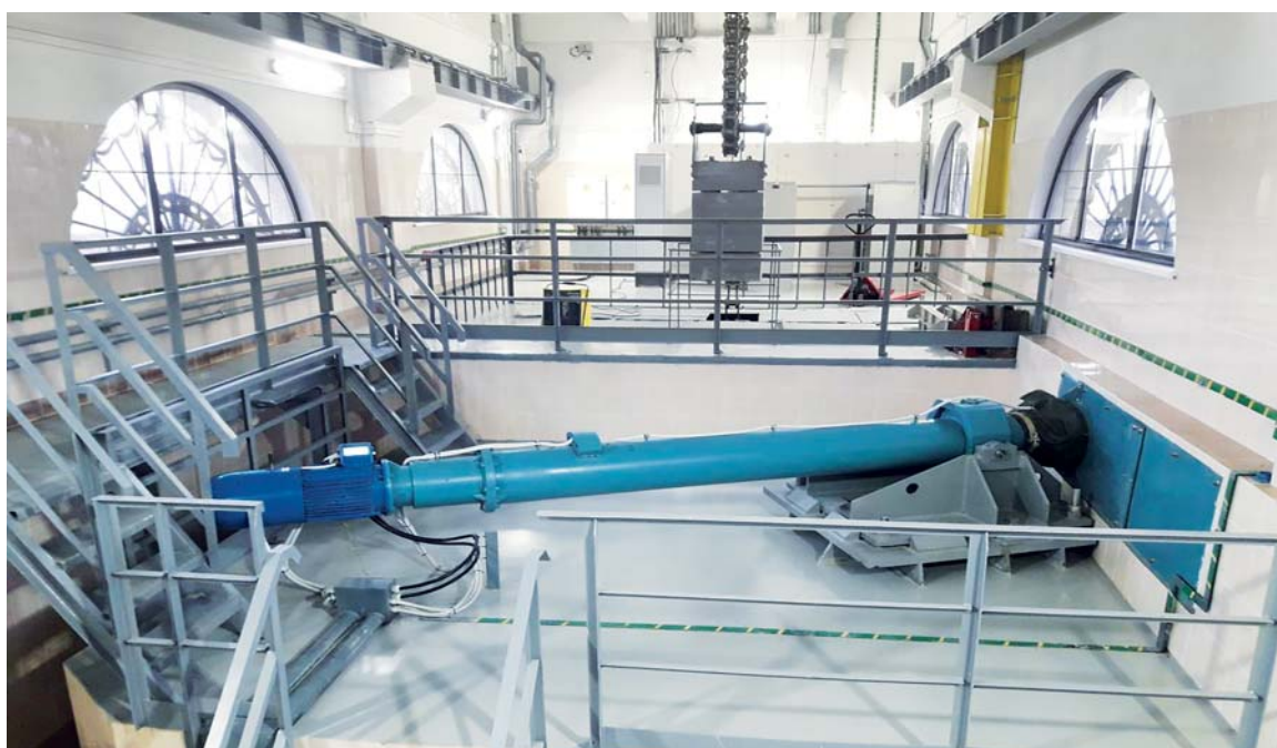
Линейный электроцилиндр привода рабочих двусторчатых ворот шлюза № 7
